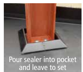
Fit pocket and apply HP-250 primer
